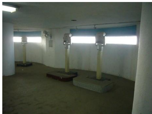
照片 2.2 觀測站內部
