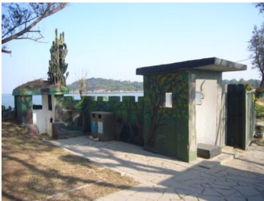
照片 2.19 混凝土灌漿
