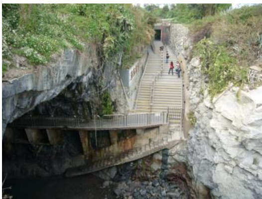
照片 2.20 入口階梯
