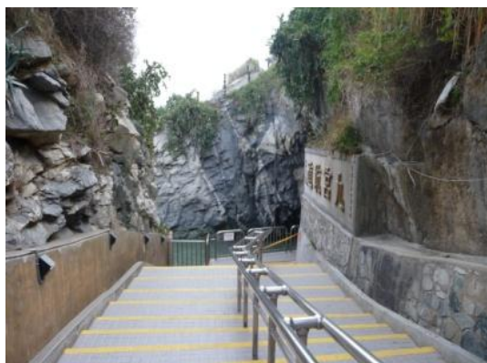
照片 2.15 混凝土樓梯，不鏽鋼扶手
