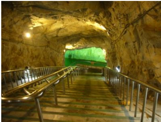
照片 2.15 混凝土樓梯，不鏽鋼扶手
